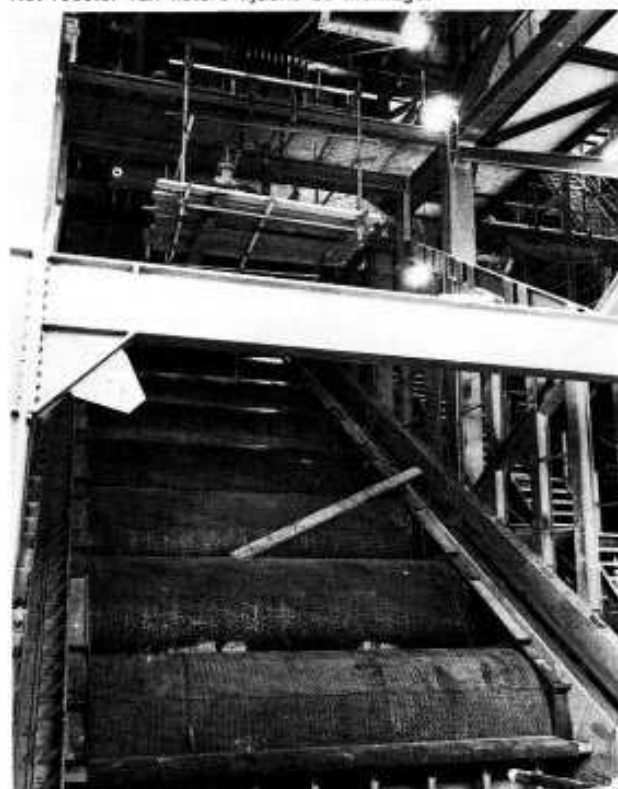
Het rooster van ketel 6 tijdens de montage.
